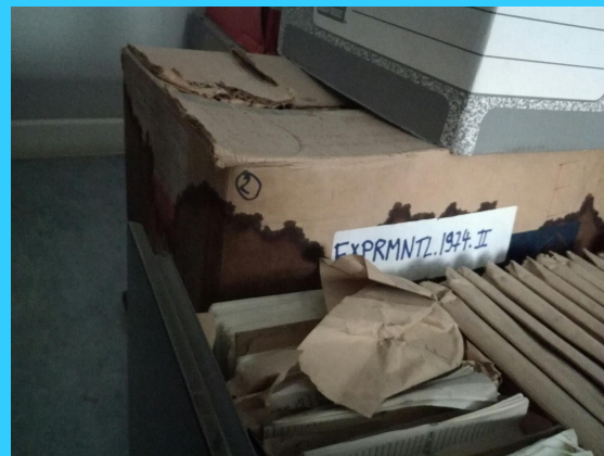
Dégâts d'eau au Palais des Congrès
